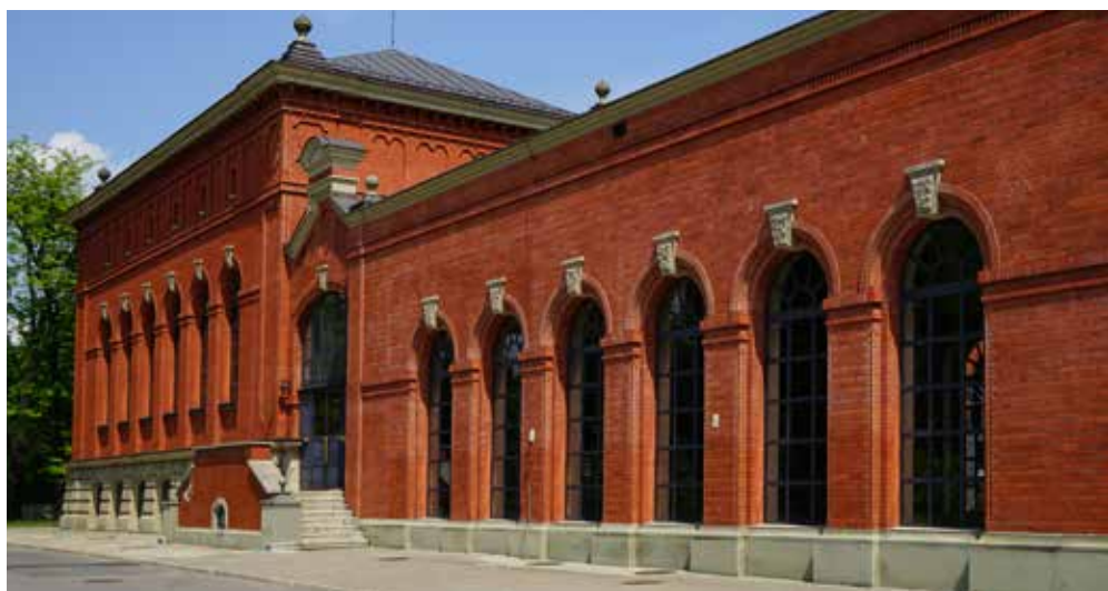
Budynek techniczny nr 1 (Hala pomp)
