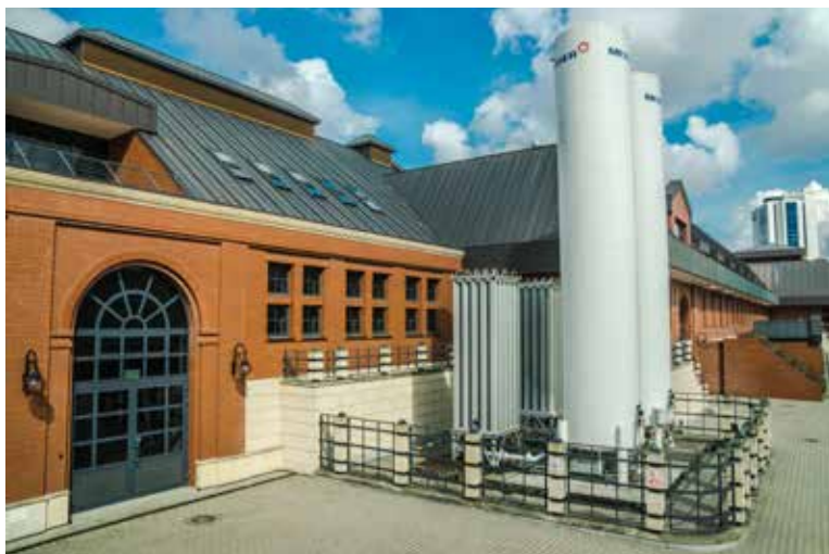
Budynek ozonowania pośredniego i filtracji na węglu aktywnym z 2010 r. nawiązujący arch. do budynków zabytkowych Stacji Filtrów
