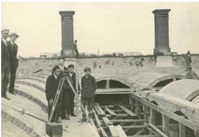
Budowa Stacji Filtrów – pomiary
