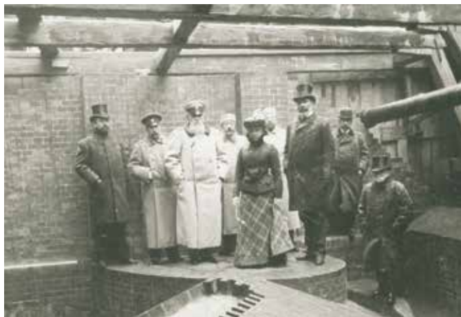
Kanał burzowy na rogu Krakowskiego Przedmieścia i ul. Karowej. William Heerlein Lindley (trzeci od prawej) z wizytą na budowie. Zdjęcie z lat 80. XIX w.
