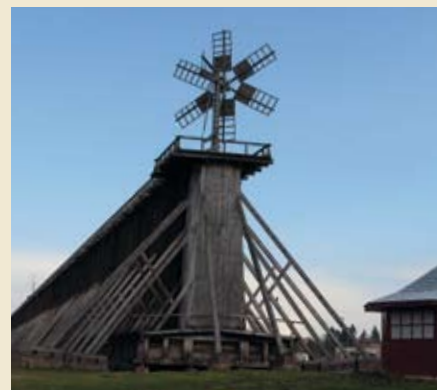
Tężnia nr 3 (rok budowy 1859). Wiatrak służył niegdyś do napędu pompy solanki.
